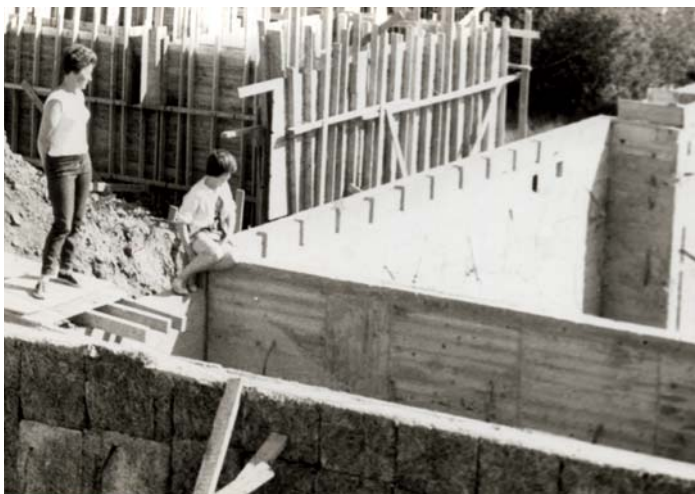
Grunnmuren er på plass, og snart kommer reisverket.
