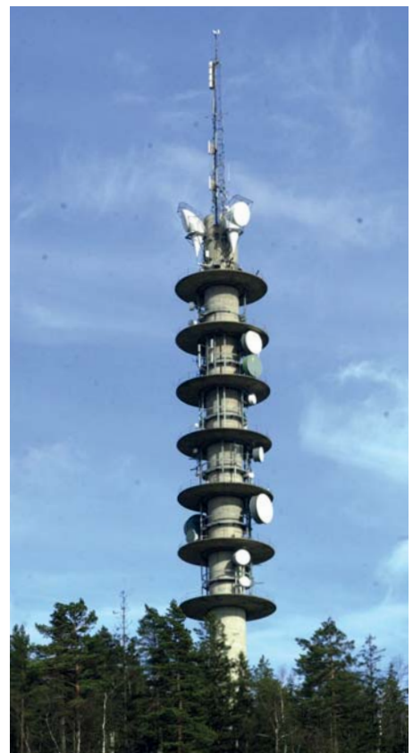
TV-masten på Røverkollen (400 m.o.h.) ble ferdigbygd i 1979. Betongtårnet rager 84 meter i været med en 29 meter høy mobilmast øverst.
