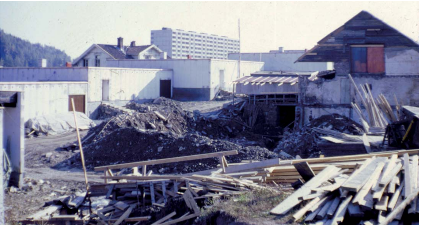
Før våningshus og låve ble revet. Husene 221-215 er ferdige, mens 195 på hjørnet kun har gravd ut tomte.
