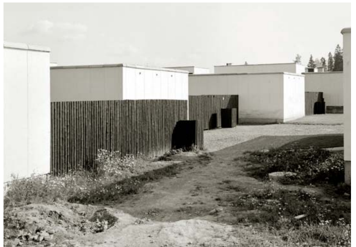
Gjerdene på plass, men veien mangler dekke.
